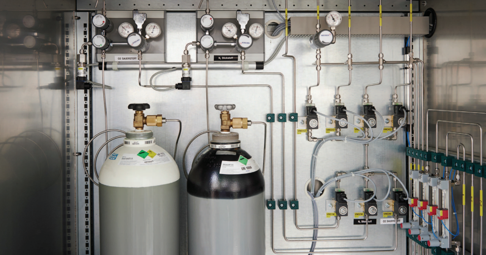
Sistem central (rețea) de alimentare cu gaz
